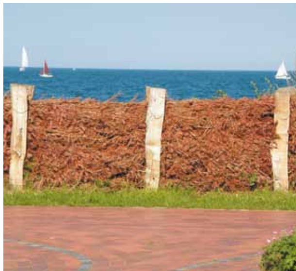
Küstenschutz mit Flechtwerkzaun
