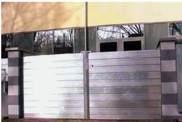
Hochwasserschutztor mit Damm balken
