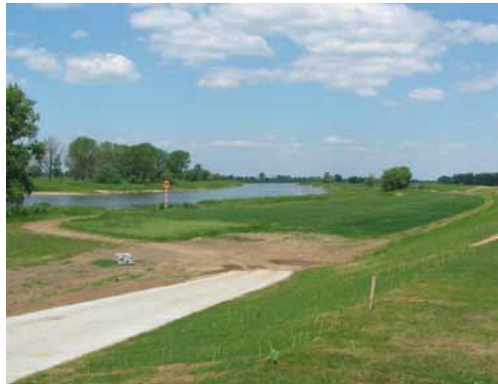
Hochwasserschutzdeich an der Elbe
