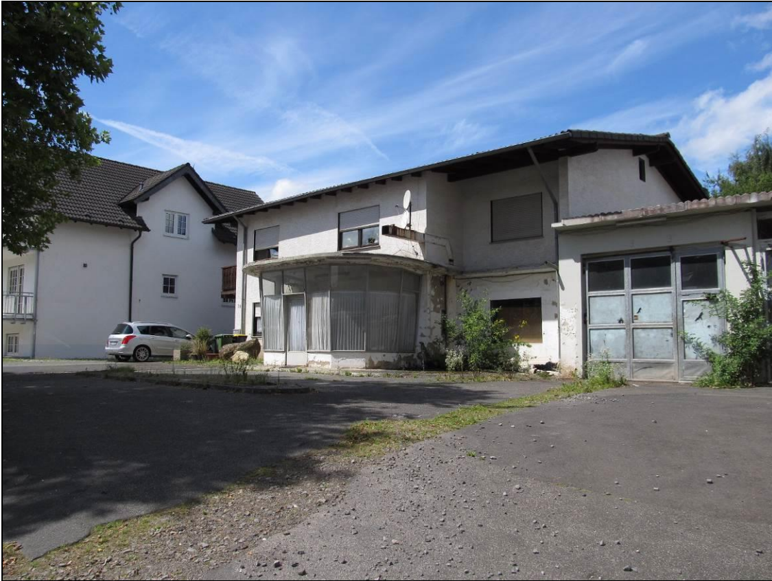
Abbildung 11: Gelände der ehemaligen Tankstelle (von der Rathausstraße aus gesehen)
