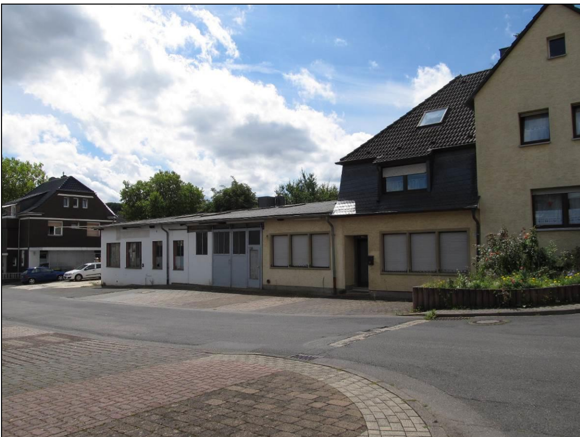
Abbildung 4: Bebauung westlich des Odenhauser Wegs (von Norden aus gesehen)
