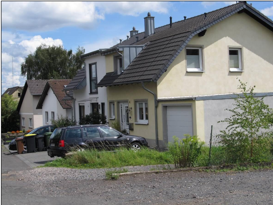
Abbildung 6: Bebauung am Nordrand des Plangebiets
