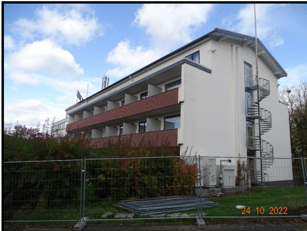
Abbildung 2: Ansicht des Untersuchungsgeländes; Blickrichtung Nordwesten
