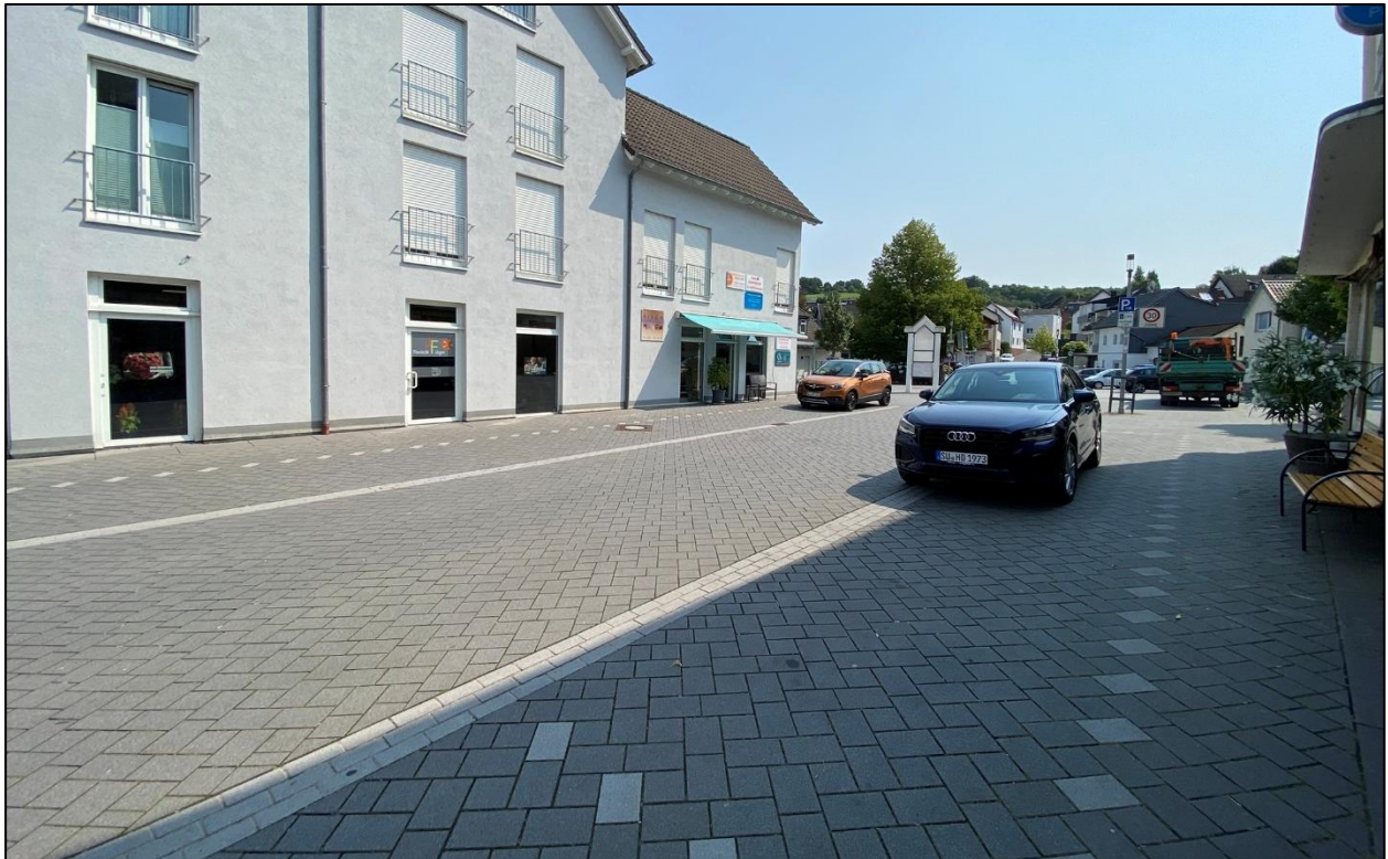
Abbildung 5: Konrad-Adenauer-Straße zweiter Abschnitt, Blickrichtung Osten [eigene Aufnahme]
