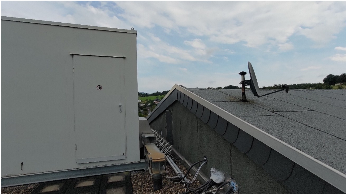
Abbildung 9: Bereich Satteldach auf dem Hauptgebäude (Foto: o.9 stadtplanung)
