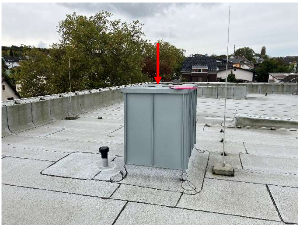
Abbildung 13: Asbestzementrohr (Dach)
