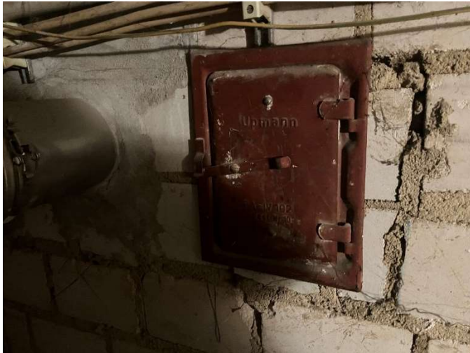
Abbildung 14: asbesthaltige Revisionsklappe
