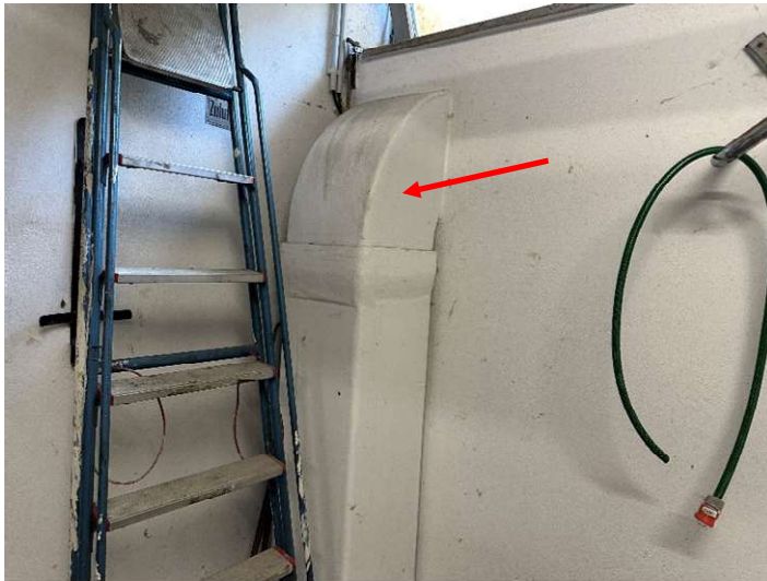
Abbildung 12: Asbestzementrohr (KG)
