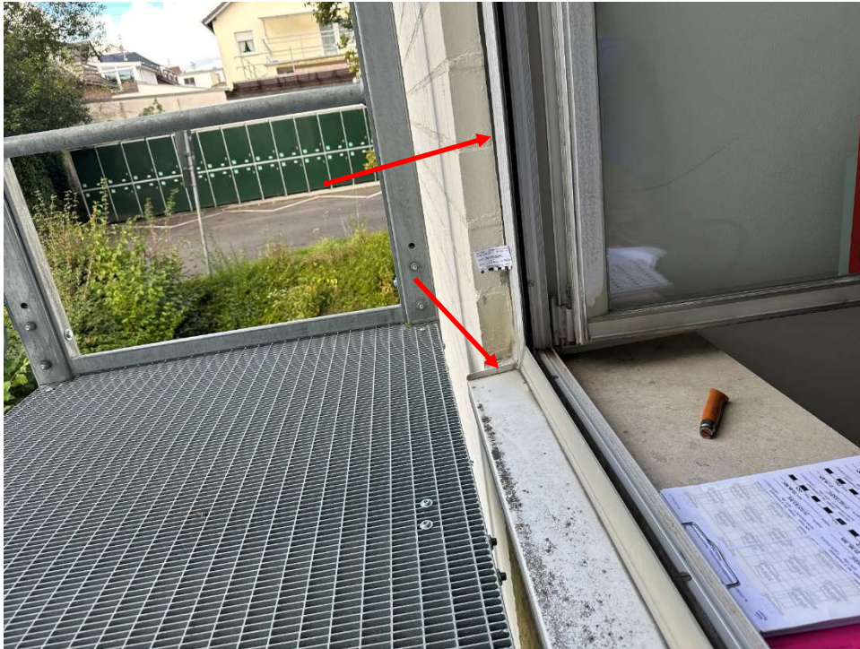
Abbildung 17: PCB-haltige Fugenmasse
