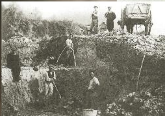
Eine terrassenförmig angelegte Tongrube
